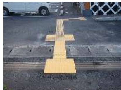
接続されている状態
