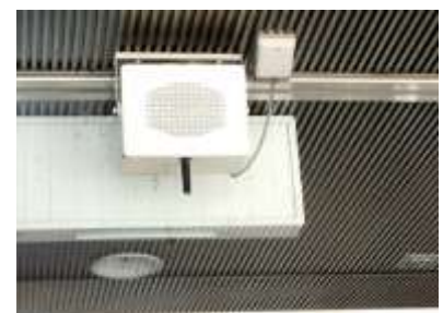
図 玄関前の底下に設置された音声誘導装置の例
