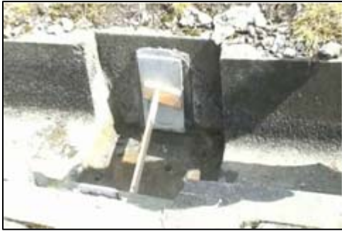
4. 取水口取り付け
