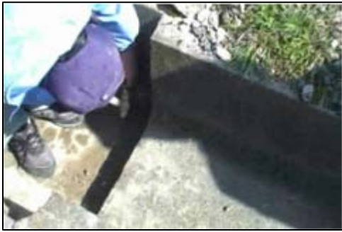
1. 取水口の取り外し
