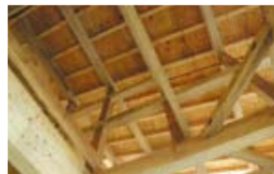
道の駅内部の構造材(LVL)
