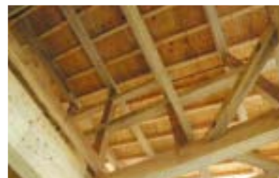
道の駅内部の構造材(LVL)
