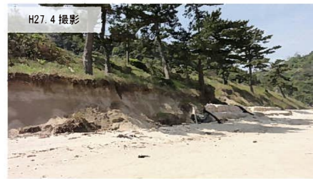
図 2.1.1 陸上海岸で発生した浜崖の状況
