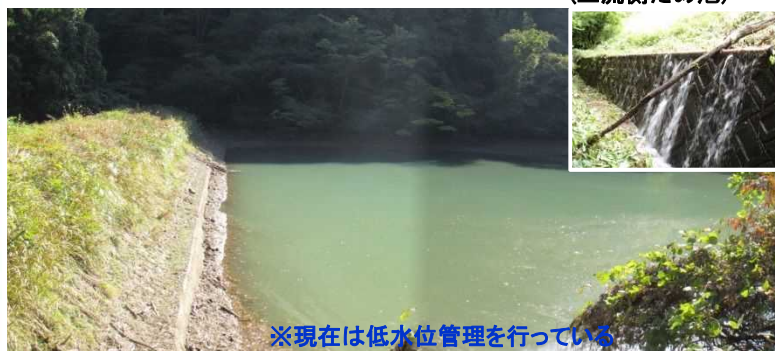
堤体からの漏水状況(上流側ため池)
