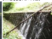
堤体からの漏水状況(上流側ため池)
