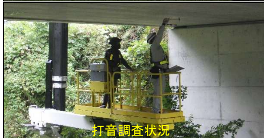
橋梁点検車を用いた点検状況
