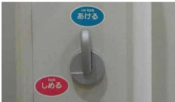
・大きめのレバーハンドル錠、色による戸の施錠/開錠表示(点字表示付き)
