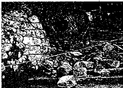
崩落した大神山神社奥宮の参道石垣
