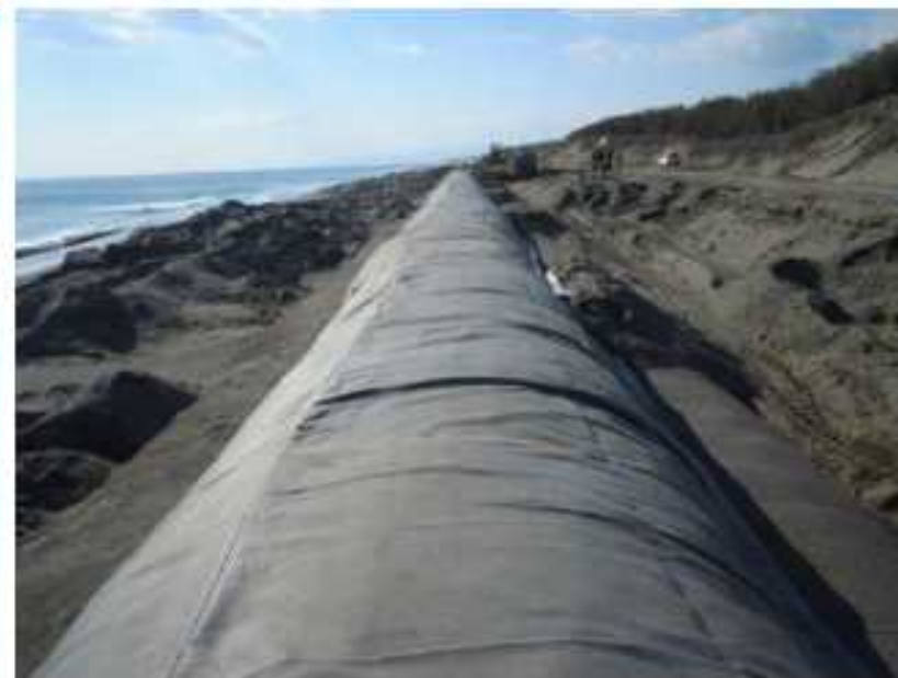
図-2 サンドバック『ジオチューブDS』
