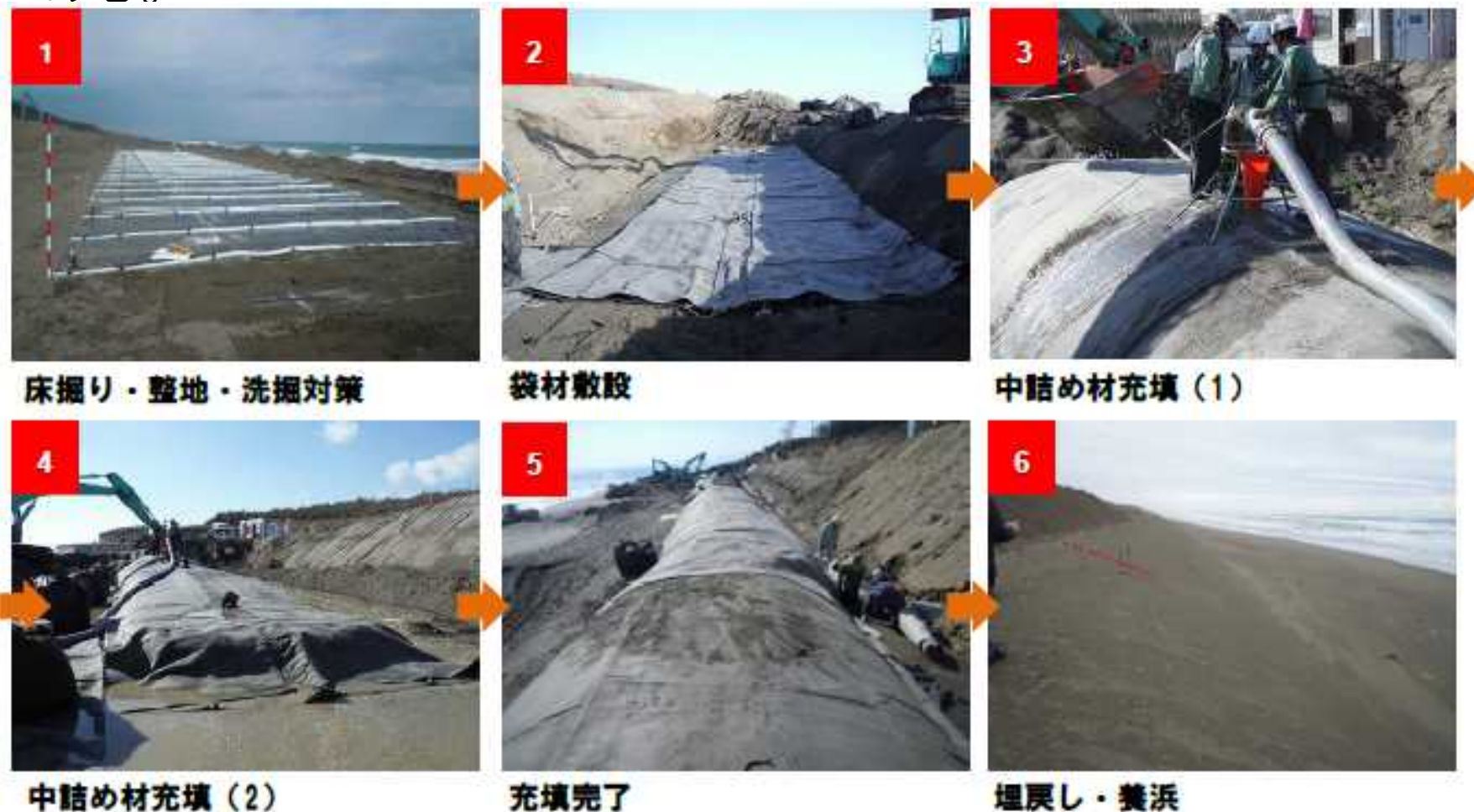
図-4 サンドパックの施工手順
