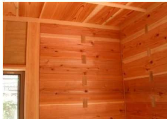
スギ厚板耐力壁は壁面がそのまま意匠になる
