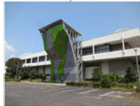
リード壁 (H28.3設置済) 高さ15m、幅10m
