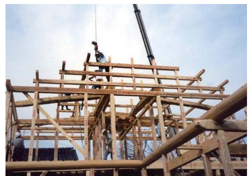
木で家を建てている様子（八頭町） やず
