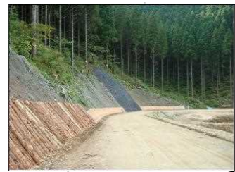
【公共事業での木材利用】 木材の需要拡大のため、行政が率先して木材を使う工夫を行っている。林道では法面の草抑えとして利用している。(日南町上萩山林道窓山線。左は(株)オロチが排出する剥き芯を利用。)
