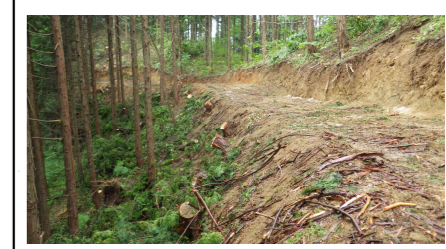
【鳥取式作業道の推進】 災害に強く、長期間の使用に耐えるように、転圧棟丁寧な施工と、早期緑化を行うための表土ブロックを施工する作業道の作設を推進している。
