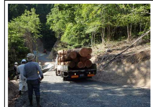
【林業専用道の整備】 林道までの木材運搬は林内作業車や2トン程度のトラックで行われていましたが、大型トラックが通行できる林業専用道を整備することで大幅な時間短縮とコスト
