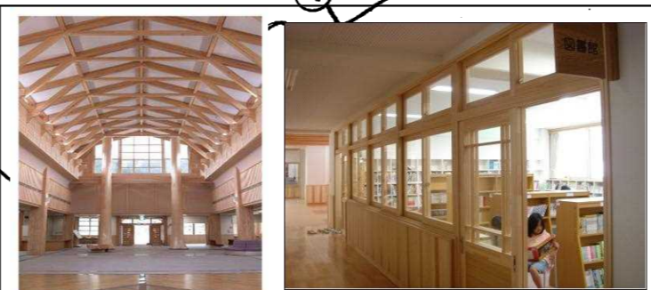
【日南町庁舎・日南小学校】 地域で生産・加工された木材を使用した木造公共施設。地域材利用のシンボル。日南小学校には(株)オロチのLVL使用。(日南町霞)
