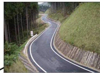
【公共事業での木材利用】 木材の需要拡大のため、行政が率先して木材を使う工夫を行っている。林道では法面の草抑えとして利用している。(日南町上萩山林道窓山線。左は(株)オロチが排出する剥き芯を利用。)
