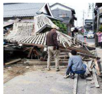
鳥取県中部地震の被災状況
