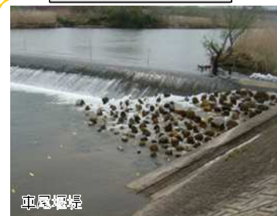
小わざ魚道化された堰堤
