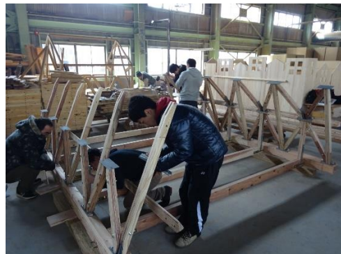
写真3 3mスパンヴォールトの施工状況
