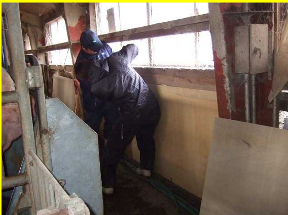
コンパネで破損カーテンを補修
