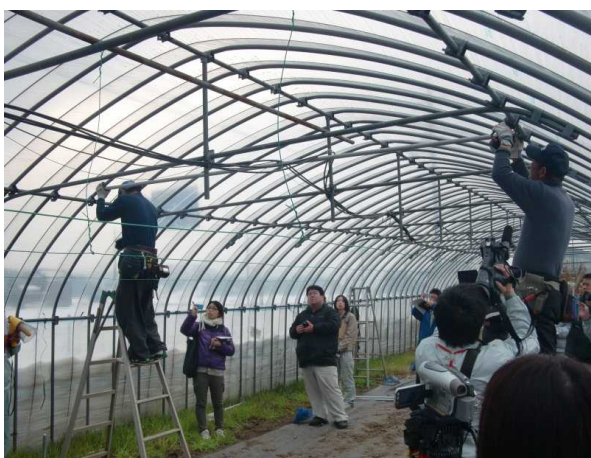
写真2 鋼管資材による補強（東部地区）
