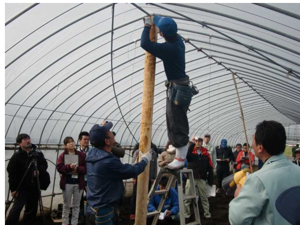
写真3 間伐材による補強（中部地区）
