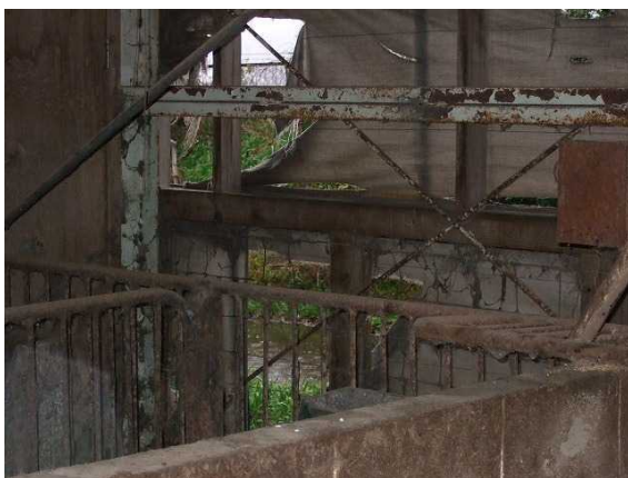
写真1 母豚舎の破損カーテン
