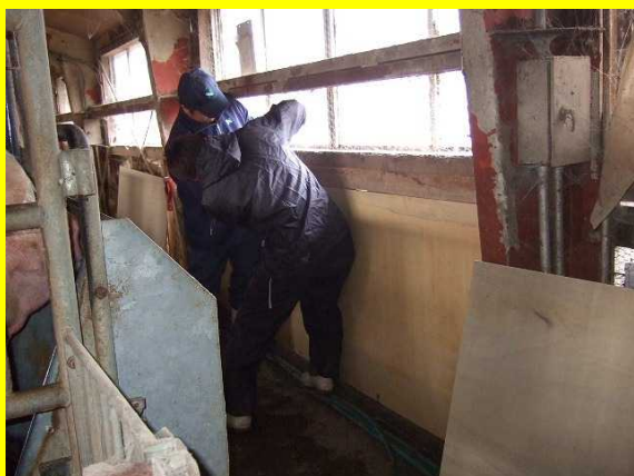
コンパネで破損カーテンを補修
