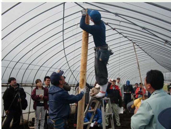
中部地区事前対策研修会（間伐材による補強）
