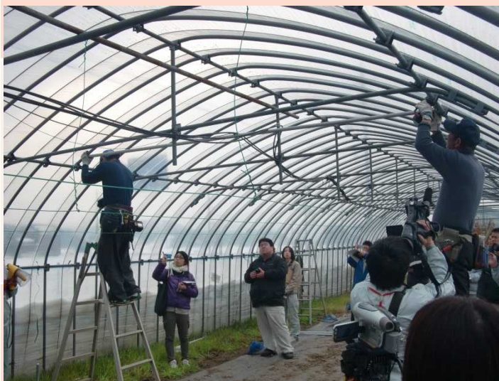
東部地区事前対策研修会（鋼管資材による補強）
