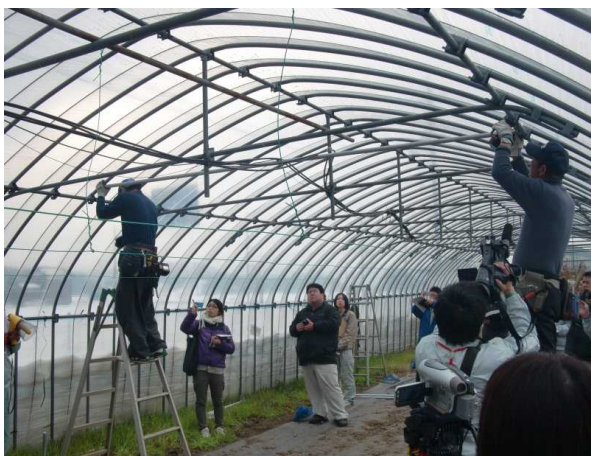
写真2 鋼管資材による補強（東部地区）
