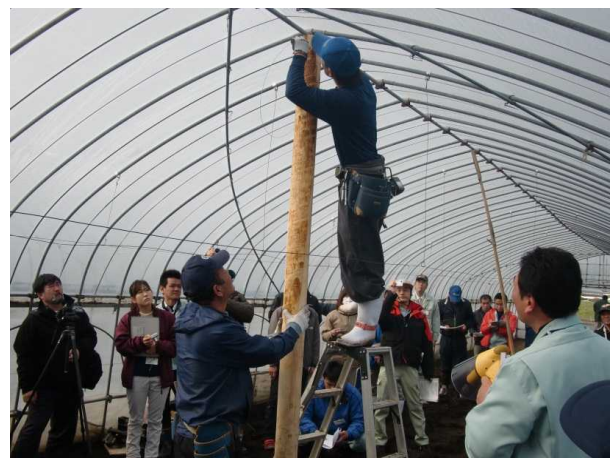
写真3 間伐材による補強（中部地区）
