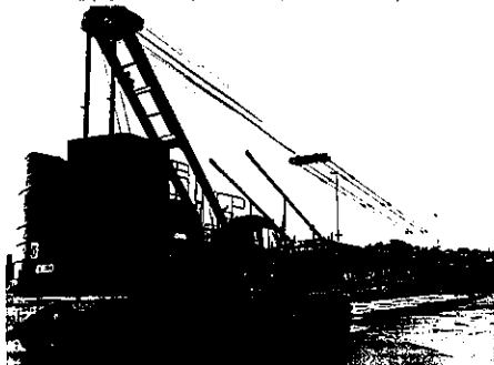
新(200t吊クローラクレーン)
