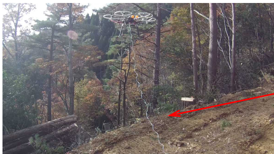
①元柱から先柱へロープを2回運搬
