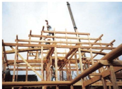
木で家を建てている様子（八頭町）
