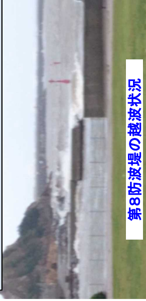
平成29年台風21号通過後の吹き返しによる港内防波堤の越波状況
