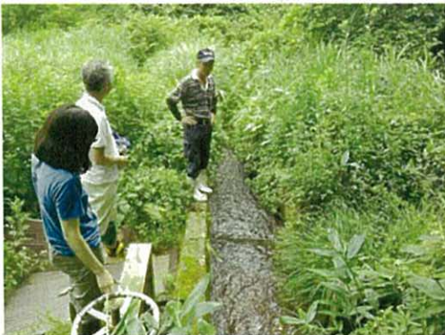
写真) 山伏水路が多く、維持管理も大変
