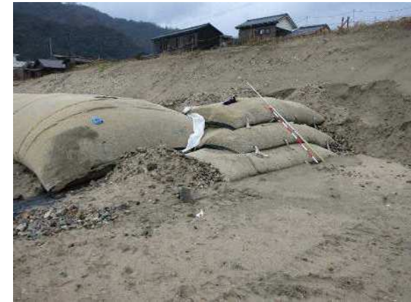
図 4-13 ミニサンドバックによる端部処理（施工時の写真）
