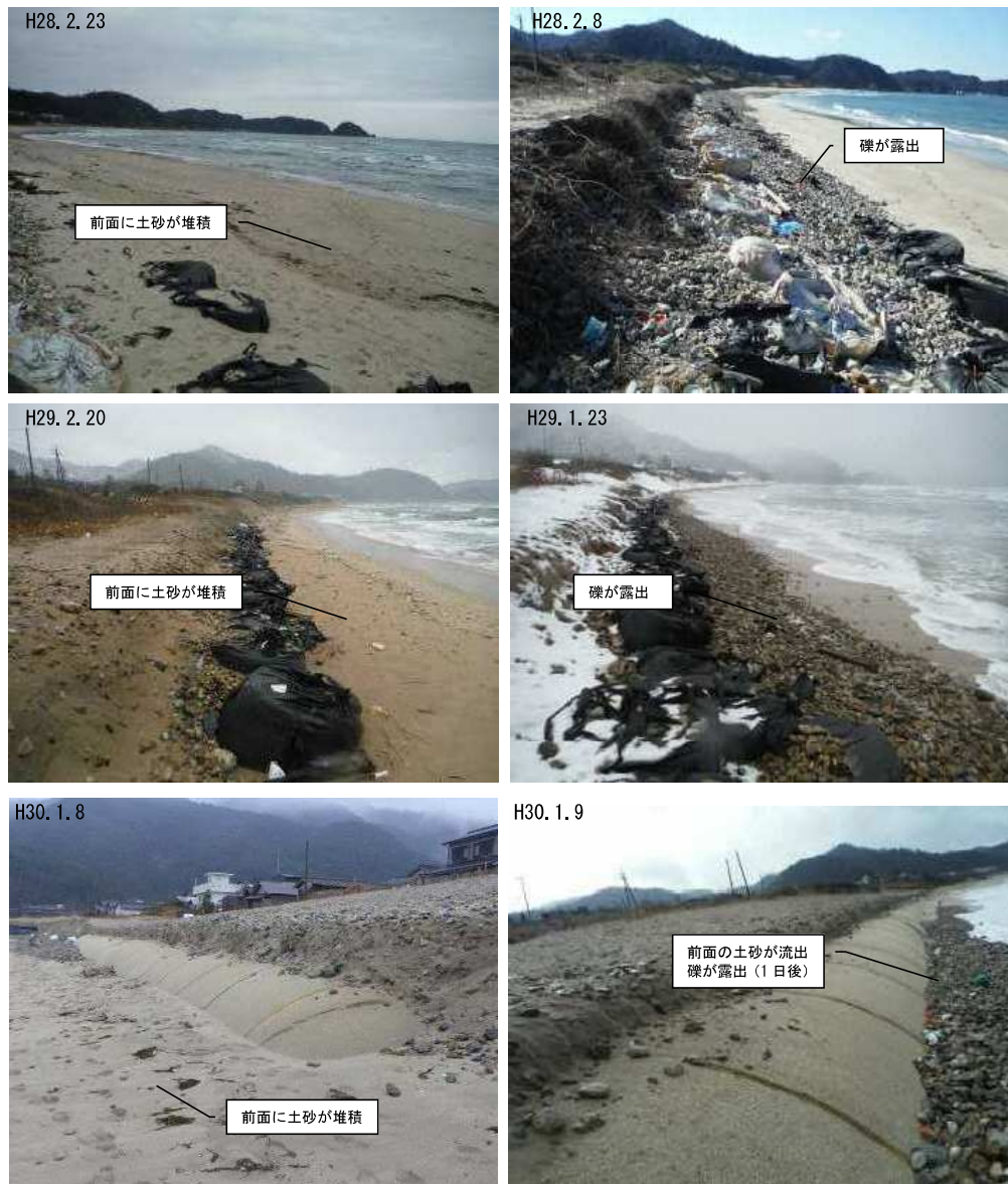
図 3-22 試験施工箇所周辺の冬季風浪時の状況（巡視時の現地写真）
