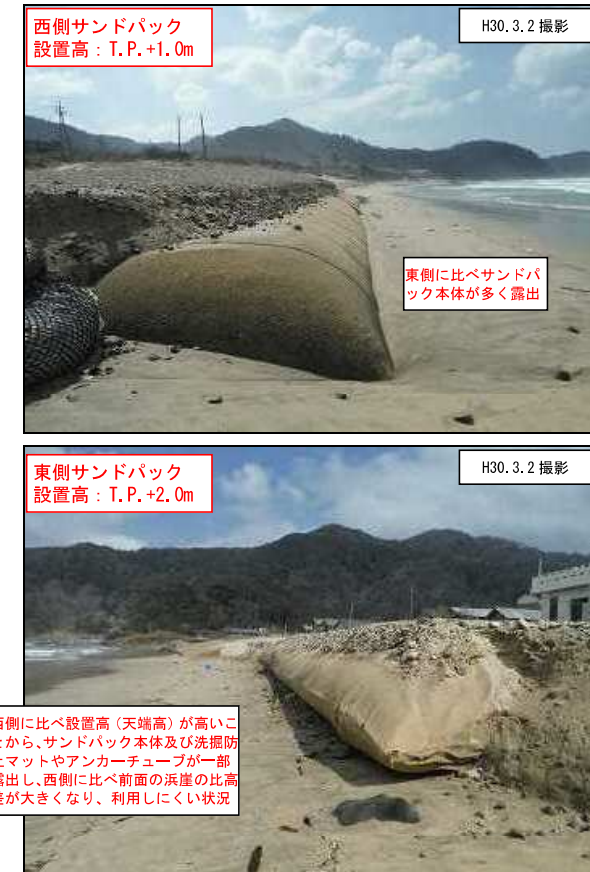
図4-10 高波浪によって露出した状況のサンドバック（上：西側、下：東側）
