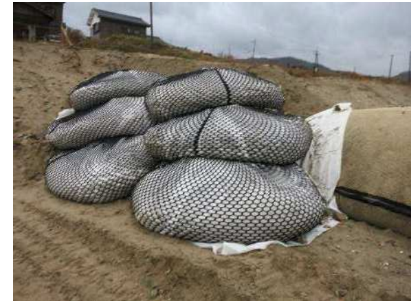
図 4-14 袋詰砂（玉石）による端部処理（施工時の写真）
