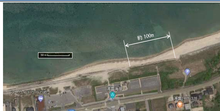
図 5-1 サンドバック試験施工箇所（消波ブロックがない区間）
