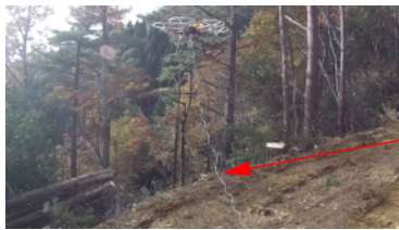
①元柱から先柱へロープを2回運搬 PP ロープ 1巻 1000m 1.4kg
