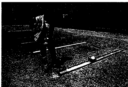
駐車場ライン引き実習(米子工業高校)
