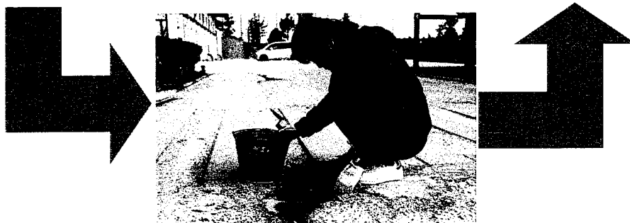
職員がすぐに補修を実施
