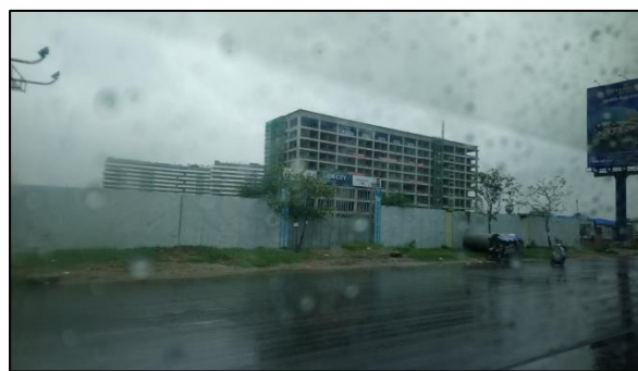
プノンペン市内のあちこちに中国資本による建物が建設中
