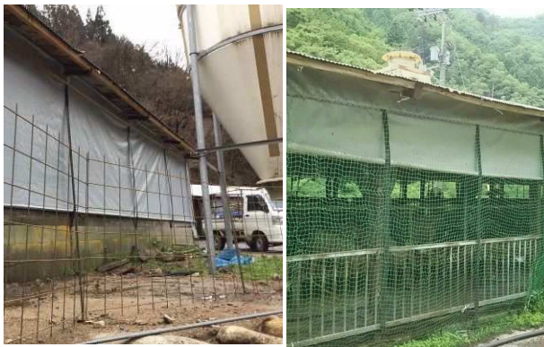
養豚場に設置した防護柵（左）と防鳥ネット（右） （鳥取県若桜町）
