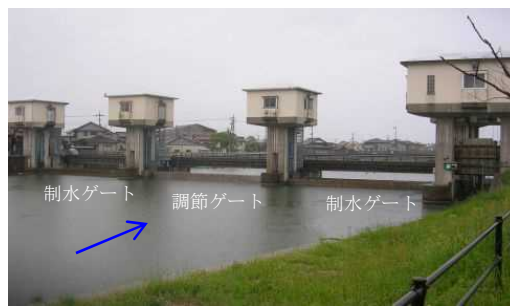
<特定構造物改築事業：橋津川水門>
