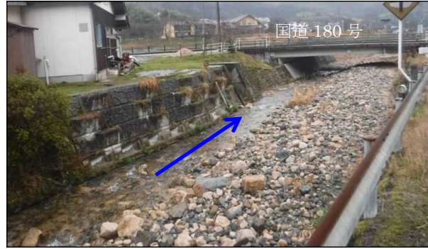
< 河道掘削：小川尻川（日野町本郷） >
