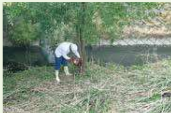
河川内の樹木伐採の様子
