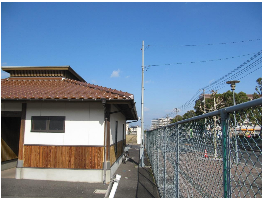
【16】大御堂廃寺といれ及びその付属物（トイレへの電線引込用電柱）
