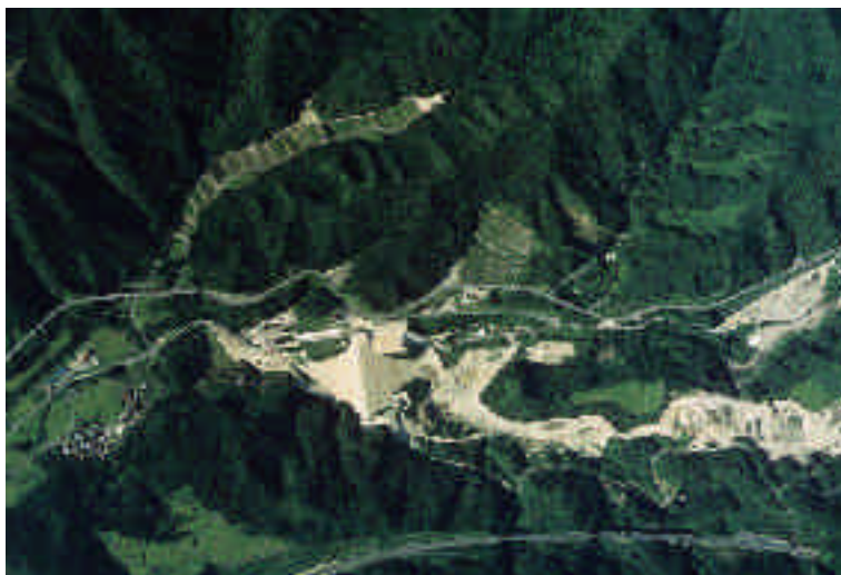
上から見た建設中の下蚊屋ダム
