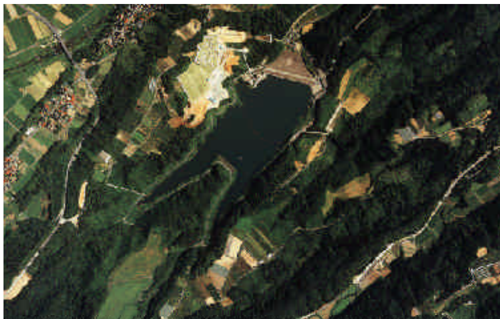
↑ にしたかお 上空から見た西高尾ダム
