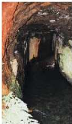
●昔の「のみ」の跡が残っているトンネル（岸本町教育委員会）
