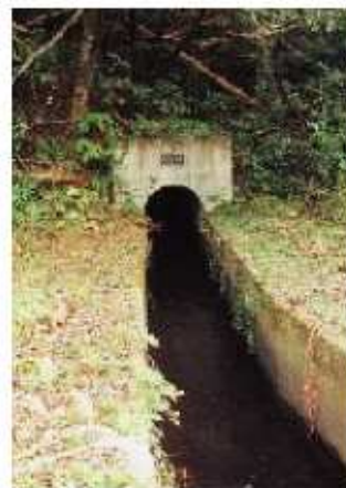
●改修されたトンネル
