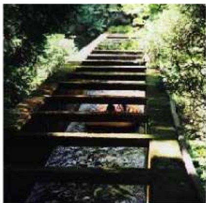
●谷を渡る水路橋
