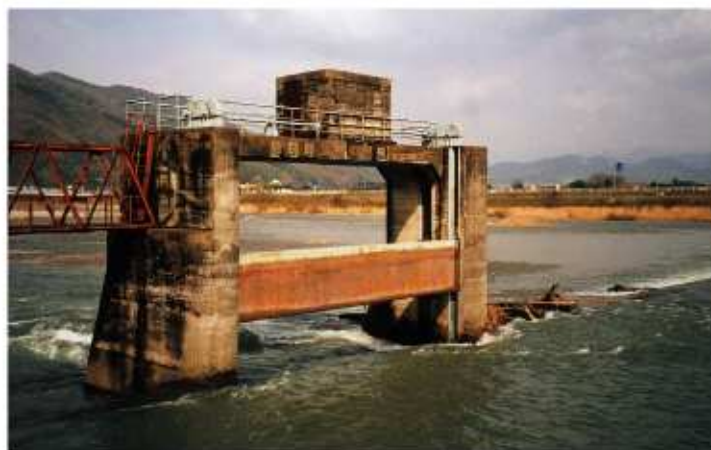
●大井手頭首工（河原町曳田） （注）
