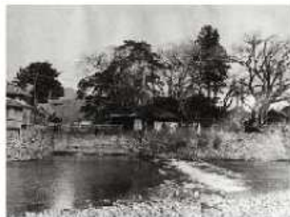
●昔の水の取り入れ口
