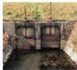
●福山大口堰の樋門
