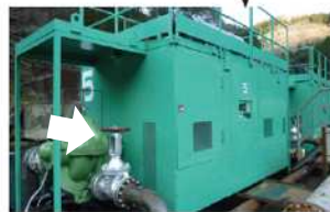
超高压ポンプ 圧力 1.95MPa、流量 5m³/min、2 台
