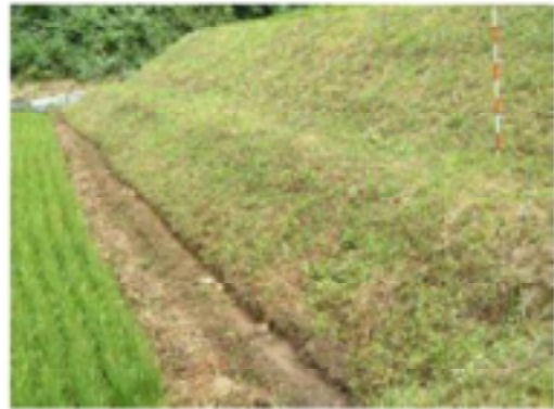
法尻位置への造成例 (八頭郡智頭町大屋)
