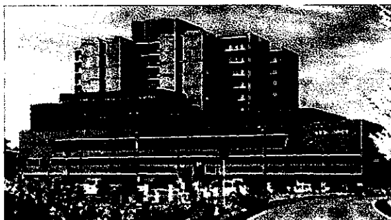
新病院の全景
