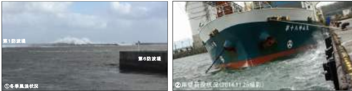
図4-4 冬季風浪状況(左)、岸壁荷役状況(右)
