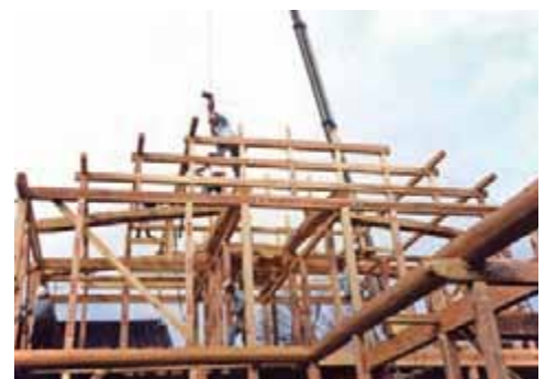
木で家を建てている様子（八頭町）
