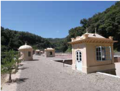
<国重要文化財>旧美歎水源地水道施設
