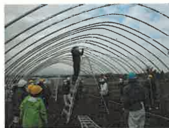
写真4 ハウス建設研修会
