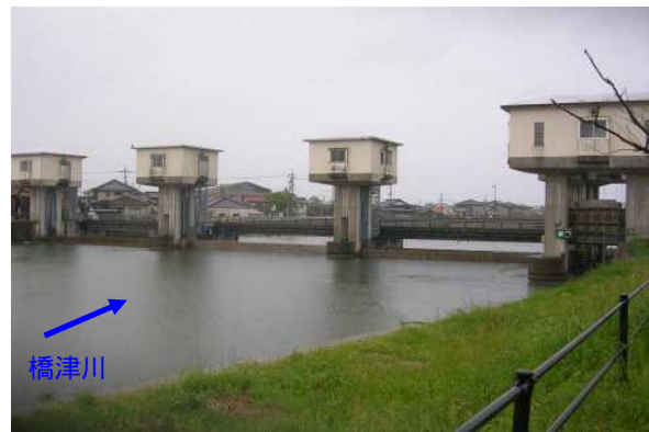
< 特定構造物改築：橋津川水門（湯梨浜町橋津） >
