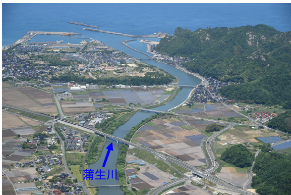
< 築堤護岸：蒲生川（岩美町岩本） >
