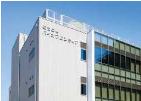
とっとりバイオフィロンティアの外観
