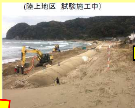
(陸上地区 試験施工中)
